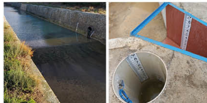
SECCIONES DE AFORO DE RESALTE DE SOLERA, PARSHALL Y POZO DE ESTABILIZACIÓN PARALELO
