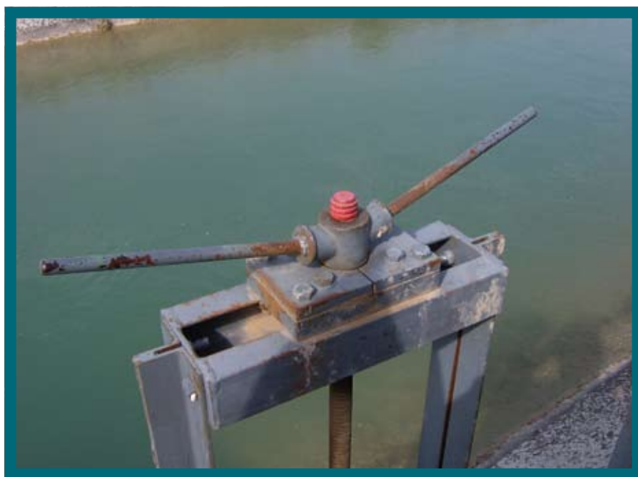
Figura 1. La gestión tradicional en canales implica la actuación manual sobre elementos aislados, lo que supone un notable gasto en personal y una baja capacidad de reacción ante variaciones de regulación.
